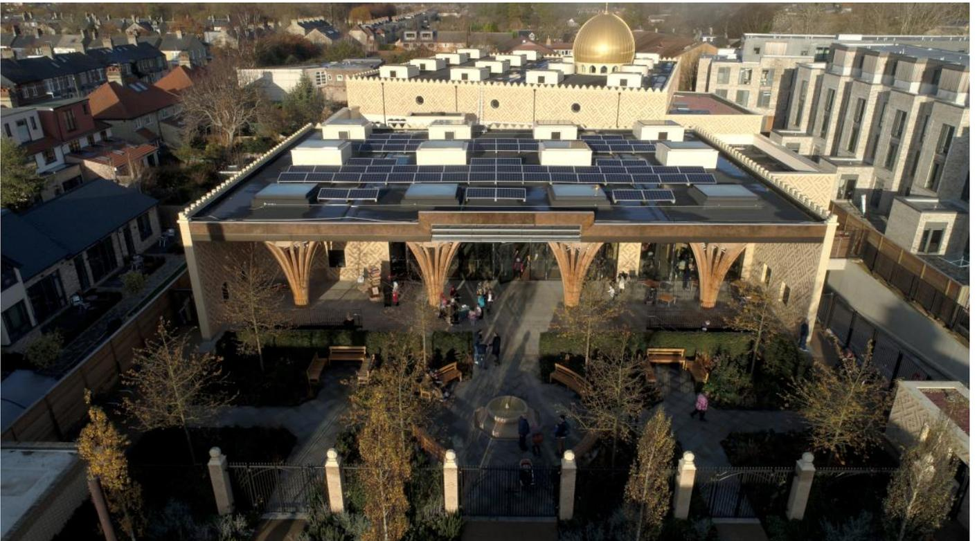
وأضاف أنه تم تركيب لوحات شمسية فوق سطح المسجد لتوليد الكهرباء، مشيراً إلى أن 30 بالمئة من احتياج المسجد من الكهرباء يتم توليدها من هذه اللوحات وتصل هذه النسبة إلى 40 بالمئة في فصل الصيف مما يساهم في تقليل نفقات المسجد على الكهرباء.
